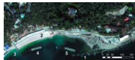
Рисунок 2 Общий вид из космоса на берегоукрепительное сооружение в санатории «Пионер» на стадии строительства (2021 г.)
