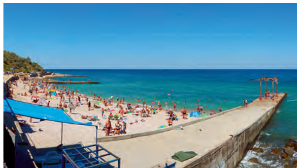
Рис. 5. Пляжеудерживающие сооружения на Северной стороне г. Севастополя
