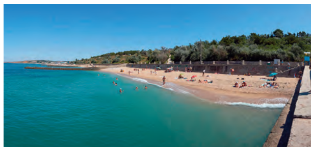
Рис. 6. Берегозащитные сооружения к югу от устья р. Бельбек
