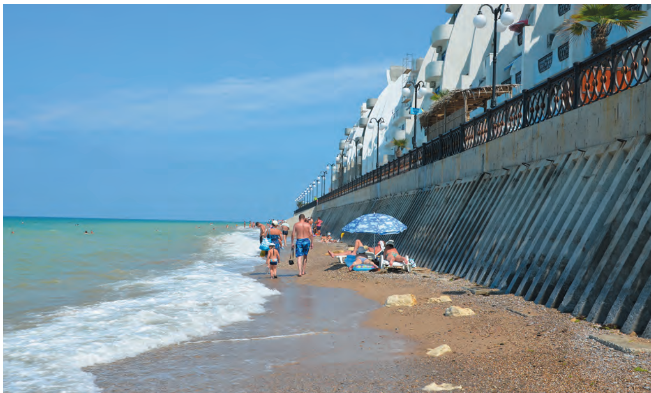
Рис. 8. Завершенный строительством участок берегозащитного сооружения в пос. Кача
