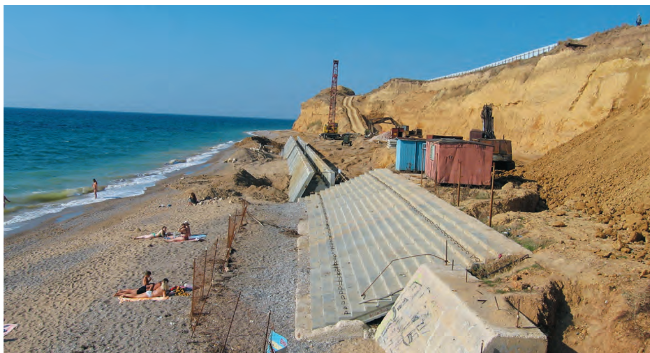
Рис. 7. Конструктивные элементы проницаемых откосных стен с волногасящей камерой в пос. Кача
